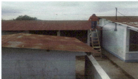
Foto1: CAMBIO DE CUBIERTAS EN COCINA Y BAÑO
