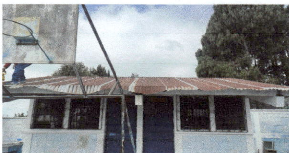
Foto 5: CAMBIO DE CUBIERTAS DE BAÑOS
