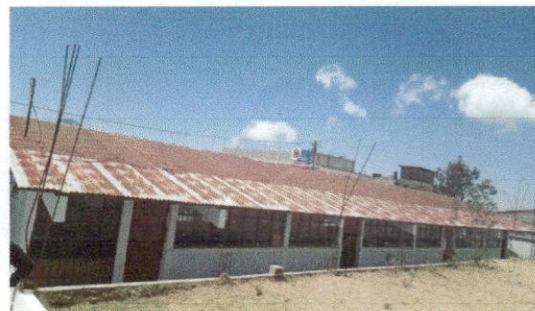
Foto 2: CAMBIO DE CUBIERTAS EN MODULOS DE AULAS
