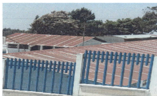
Foto 4: CAMBIO DE CUBIERTAS EN MODULOS DE AULAS
